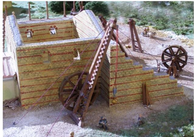
*Muros de opus vittatum mixtum, grúas de diversas formas y potencias, andamios y caos de elementos constructivos aparecen por doquier.*
