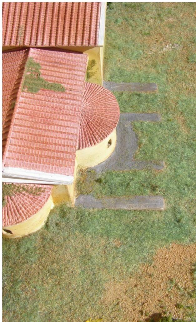
*La extraña estructura gris que asoma en la superficie del terreno son unos muros de cemento de hasta cinco metros de profundidad que se construyeron para contener un terreno muy inestable debido al agua de escorrentía.*
